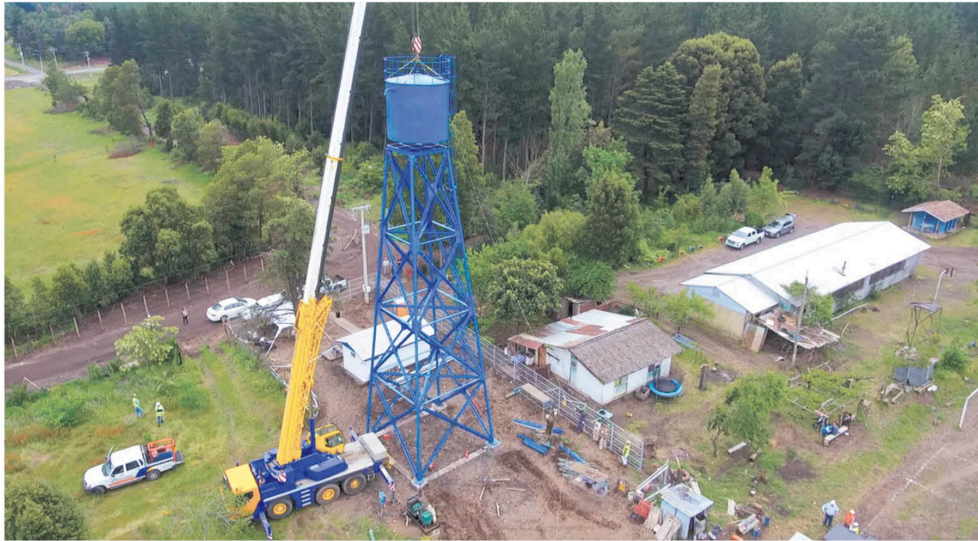
Los Ángeles es una de las comunas que más sistemas de Agua potable Rural ha construido en nuestro país. (Imagen referencial).
