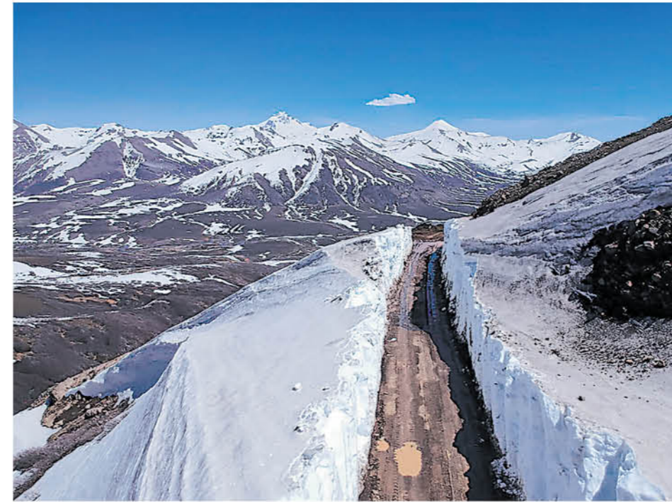
PARA CONVERTIRLO EN UN PASO de nivel mundial, paralelo al nuevo edificio se trabajará en el asfalto o pavimento de los 60 kms que hay entre Abanico y el hito fronterizo.
