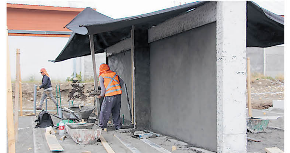
EN TUCAPEL ya comenzó la construcción de 600 viviendas
