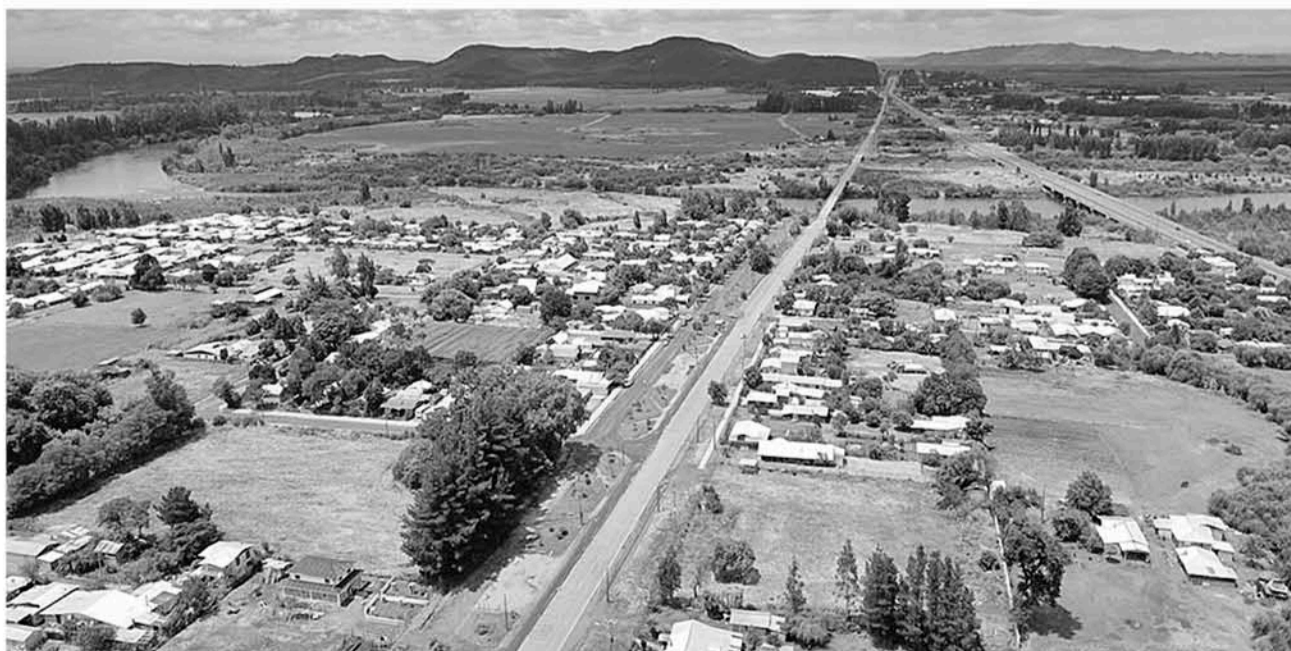
EL PROYECTO CONTEMPLA 220 CONEXIONES SANITARIAS y 212 uniones domiciliarias, con una longitud total de red de alcantarillado de 4 mil 405 metros.
