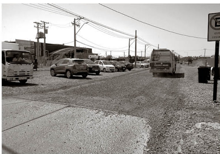
LA EMPRESA INGESP será la responsable de pavimentar la avenida Oriente.
