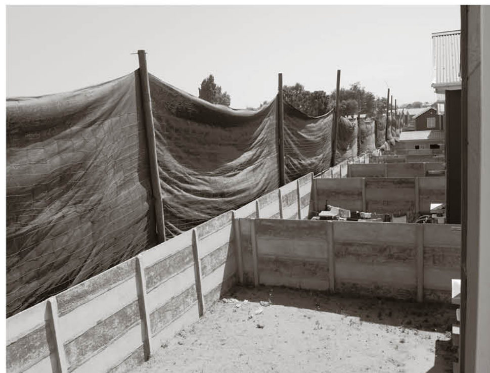
LAS MALLAS DE PROTECCIÓN serán ampliadas y reforzadas por la constructora a fin de minimizar el impacto del polvo ocasionado por las obras contiguas al conjunto habitacional.
