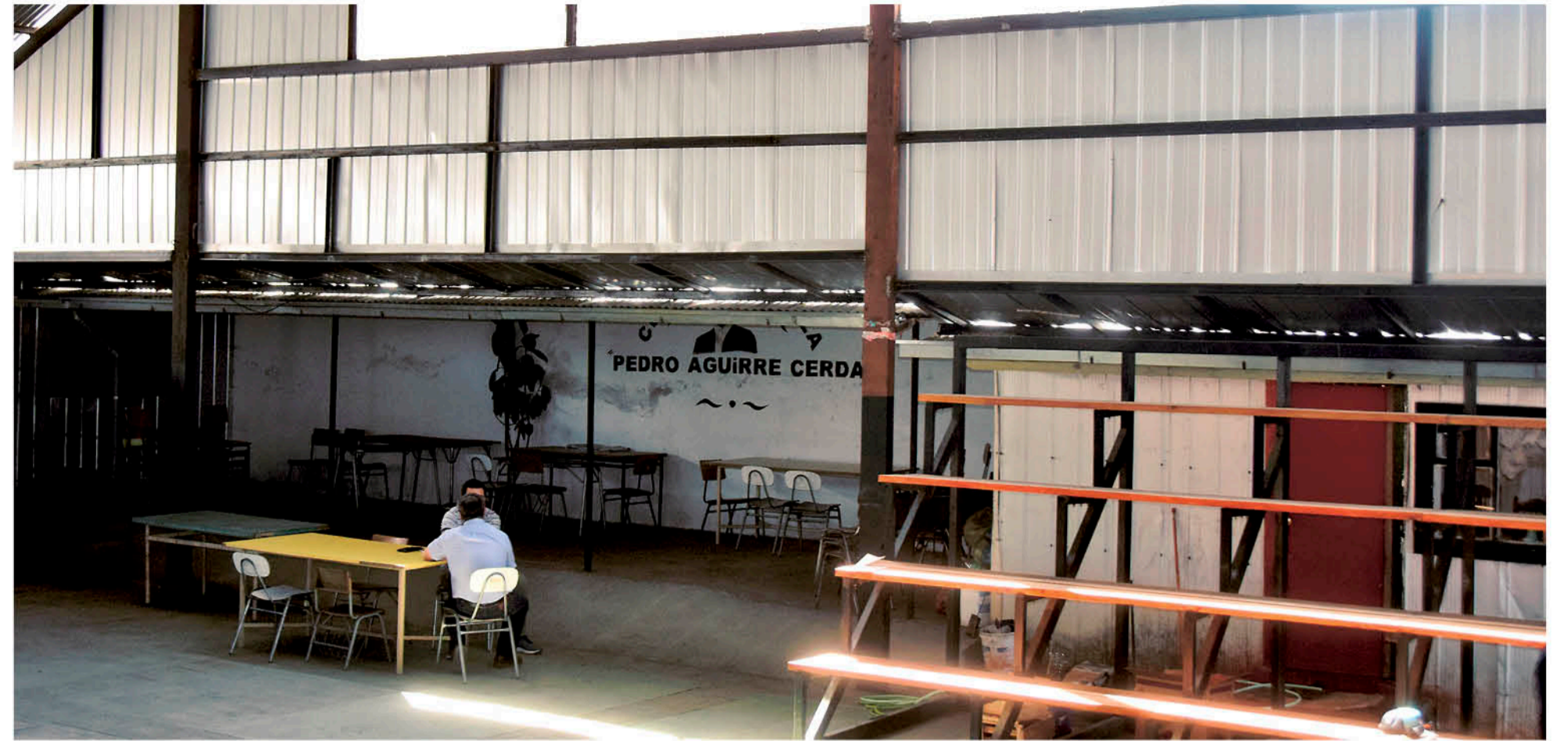
ACÁ SE EMPLAZABA ANTIGUAMENTE el muro de contención que cedió tras el terremoto del 27 F, actualmente una construcción totalmente renovada, perteneciente al Club Pedro Aguirre Cerda.
