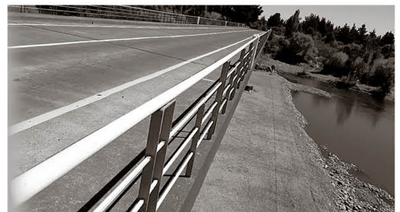
EL EDIL DIJO que los trabajos estructurales del puente fueron "ineficientes".
