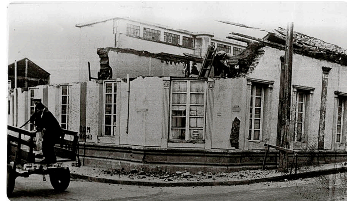
LA FOTOGRAFÍA DE LA ESQUINA de calles Colo Colo con Valdivia muestra los daños por el terremoto de 1960.
