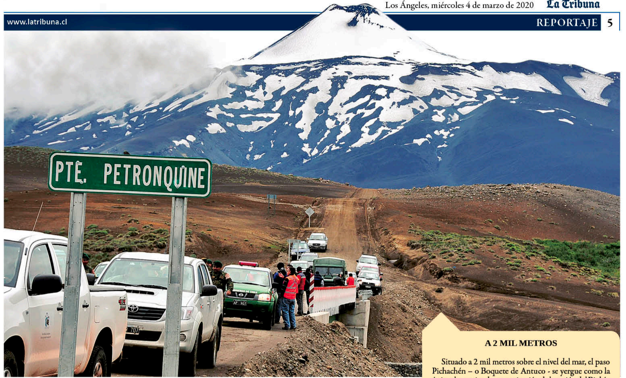
EL MEJORAMIENTO DE LOS PUENTES fue fundamental para mejorar el estándar de la vía que ahora se quiere pavimentar hasta el hito.
