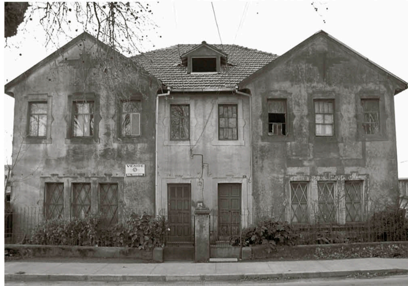
CASAS GEMELAS antes de la remodelación.
