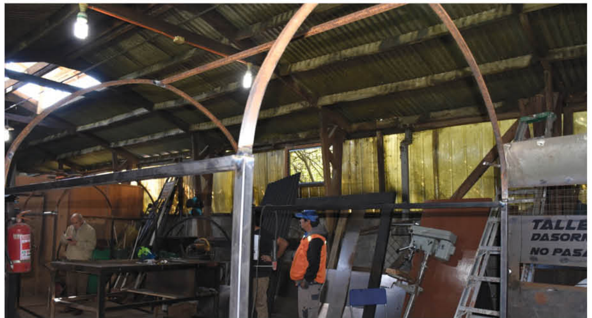
EN LA COMUNA SANTUARIO ACTUALMENTE se están fabricando otros elementos (3), los que serán ubicados en distintos sectores de la comuna que registren aglomeración de personas.
