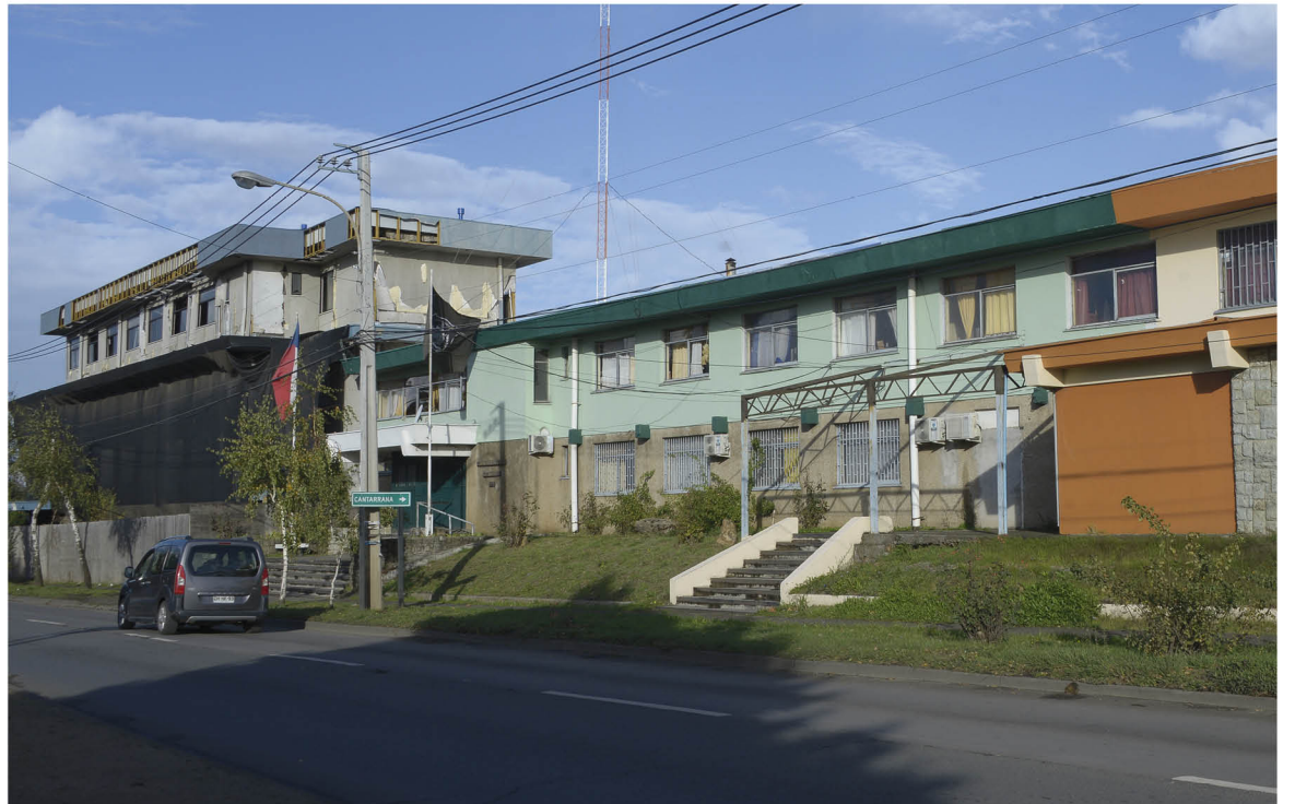
EL RECINTO DE LA CÁRCEL de Los Ángeles fue dañado por el terremoto del 27 de febrero.
