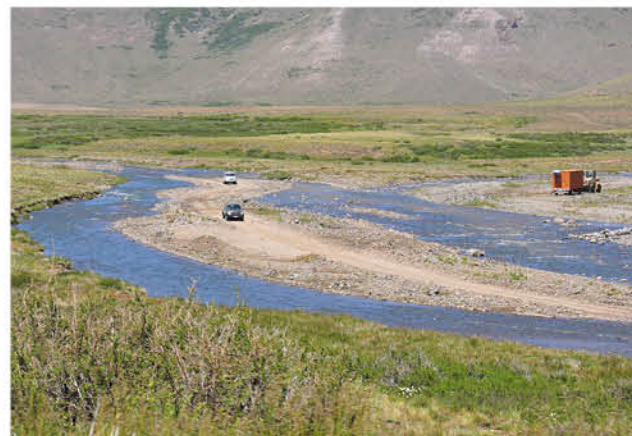
PARA PICHACHÉN se trabaja en dos frentes: la carretera y la infraestructura del Paso Internacional.
