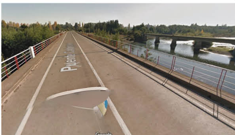
AGUAS ARRIBA DEL PUENTE CALDERONES, en la fotografía, se levantará el nuevo viaducto que unirá a Quilleco con Santa Bárbara.
