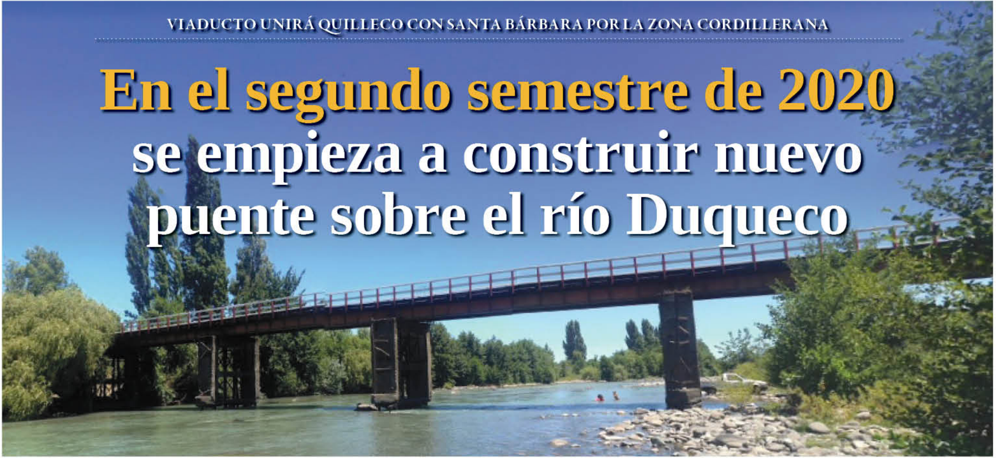
EL PUENTE DUQUECO será sometido a una completa reposición.
