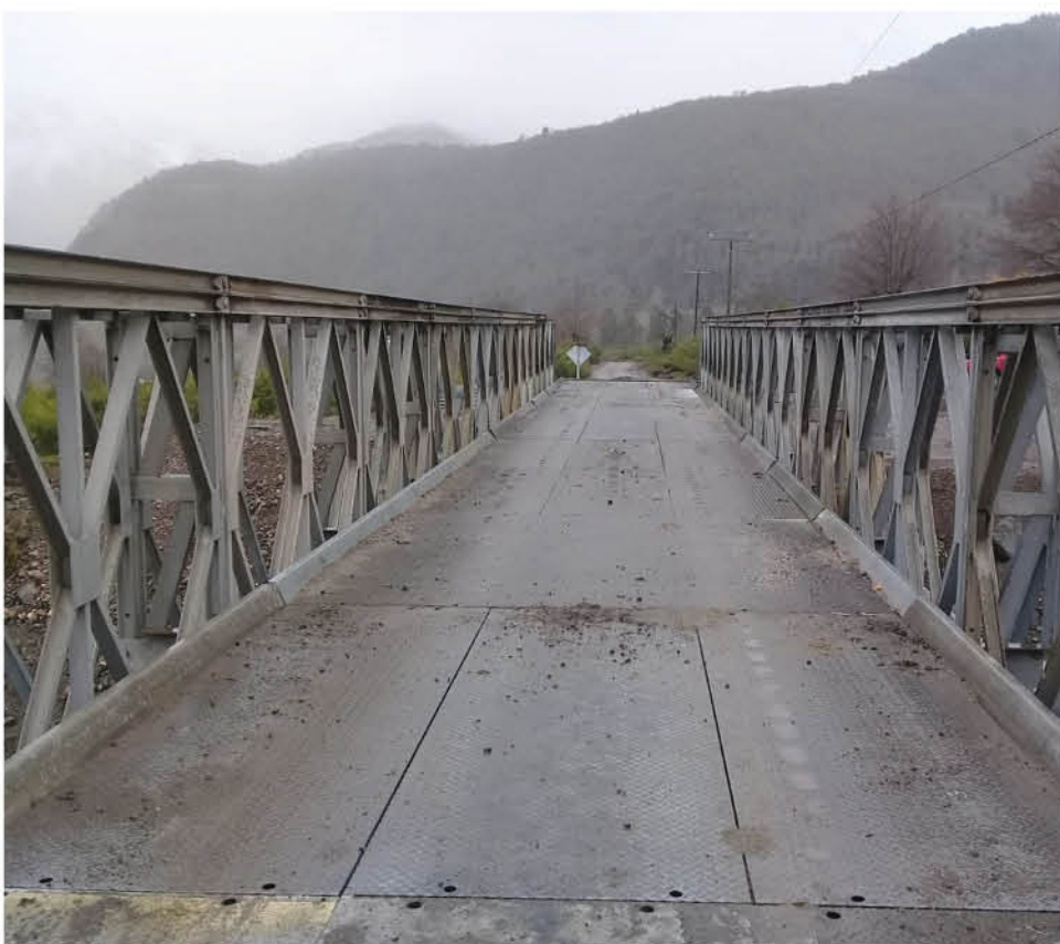
NUEVO PUENTE MECANO en Alto Biobío.
