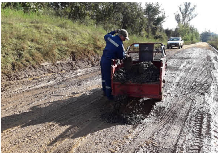
DON ALADINO en plena faena de tratar de bachear algunos de los hoyos en el camino entre Mulchén y Negrete.
