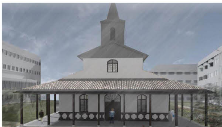
EL PROYECTO, con un valor cercano a los 2.000 millones de pesos, permitirá recuperar su integridad para recibir a usuarios, funcionarios del hospital, familiares, grupos pastorales y la comunidad en general.
