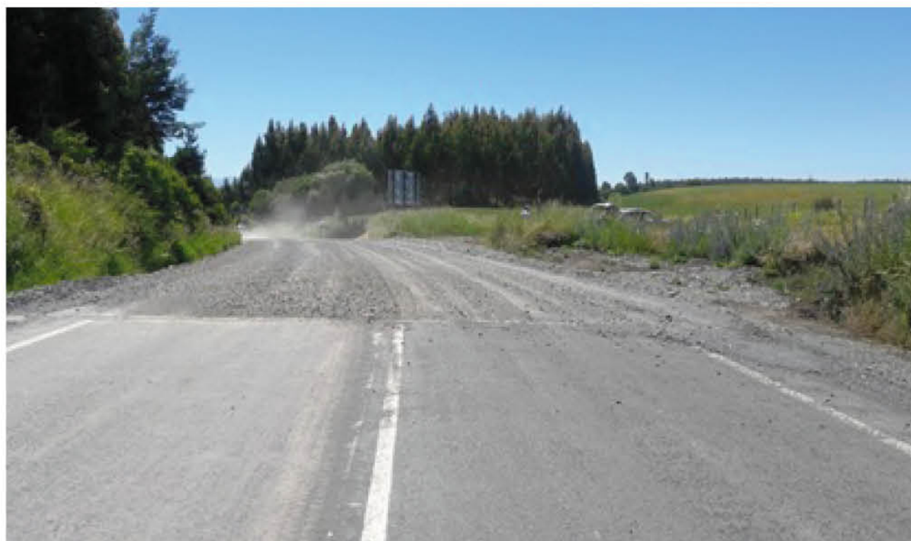
LA IMAGEN MUESTRA EL PUNTO EXACTO donde se llevarán a cabo los trabajos de pavimentación del último tramo del camino entre Quilaco y Mulchén.
