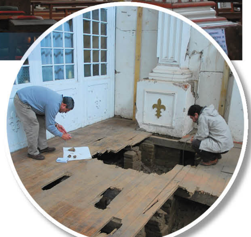
LA FALTA DE FINANCIAMIENTO para su restauración obligó a dejar la capilla del hospital en las mismas condiciones.
