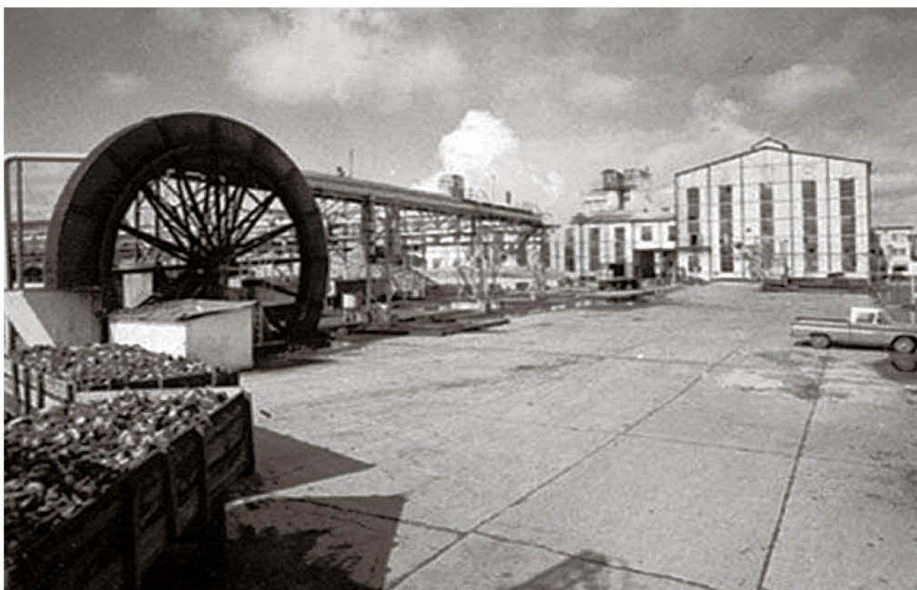
YA EN ABRIL DE 1954, LA PLANTA ESTABA PRODUCIENDO el primer kilo de azúcar de confección netamente nacional que provino de los campos de la zona de Los Ángeles.
