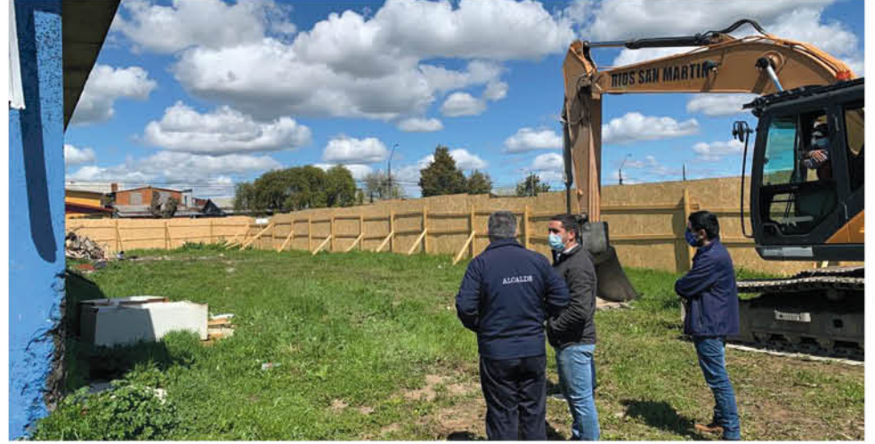
CON LA DEMOLICIÓN DEL EDIFICIO, se da un paso más para concretar la prolongación del eje de avenida Ricardo Vicuña, que ya se encontraba previsto en el Plano Regulador del año 1.991.
