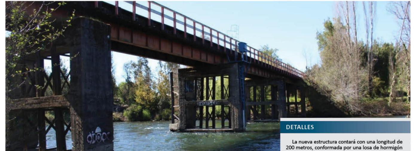
LA ACTUAL ESTRUCTURA es unidireccional y sólo permite el tránsito de camiones con un máximo de 10 toneladas.
