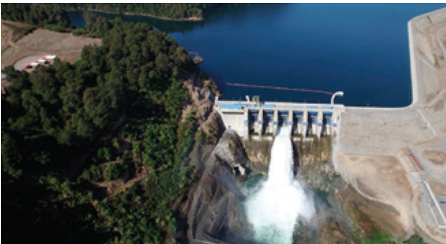
Central hidroeléctrica Angostura
