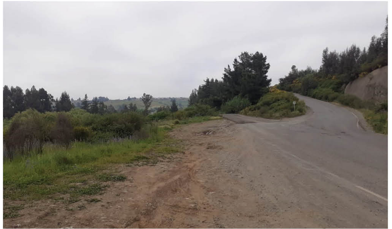
LA INVERSIÓN PARA “PAVIMENTAR” el ingreso sur implica cerca de 800 millones de pesos que serán financiados luego de un proyecto presentado por el municipio al SERVIU.
